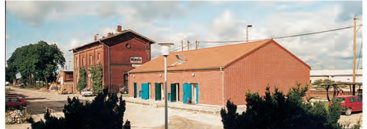
in diesen Neubauten an der Strecke sind die abgesetzten Stellrechner untergebracht
