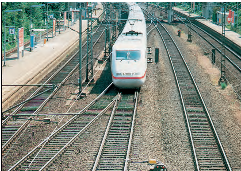
Sicherungstechnik an einer Hochgeschwindigkeitsstrecke. Der Linienleiter in der Gleismitte ist Autobahn für Daten-telegramme zwischen ICE und Stellwerk
