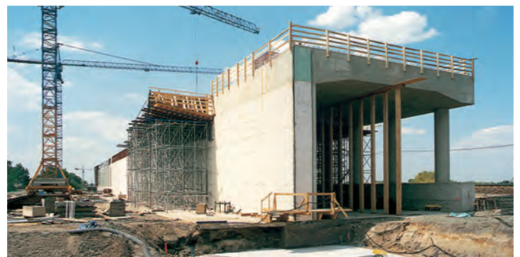
Die beiden Kreuzungsbauwerke aus der Bodenperspektive .....
