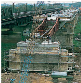
Die alten Pfeiler aus dem Jahre 1870 wurden ertüchtigt und mit Naturstein verkleidet. Darüber liegt der Vorbauschnabel, der an der Fahrbahnplatte befestigt ist.
