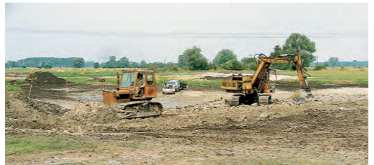
Erdarbeiten zur Anlage von Kleingewässern bei Döbbellin
