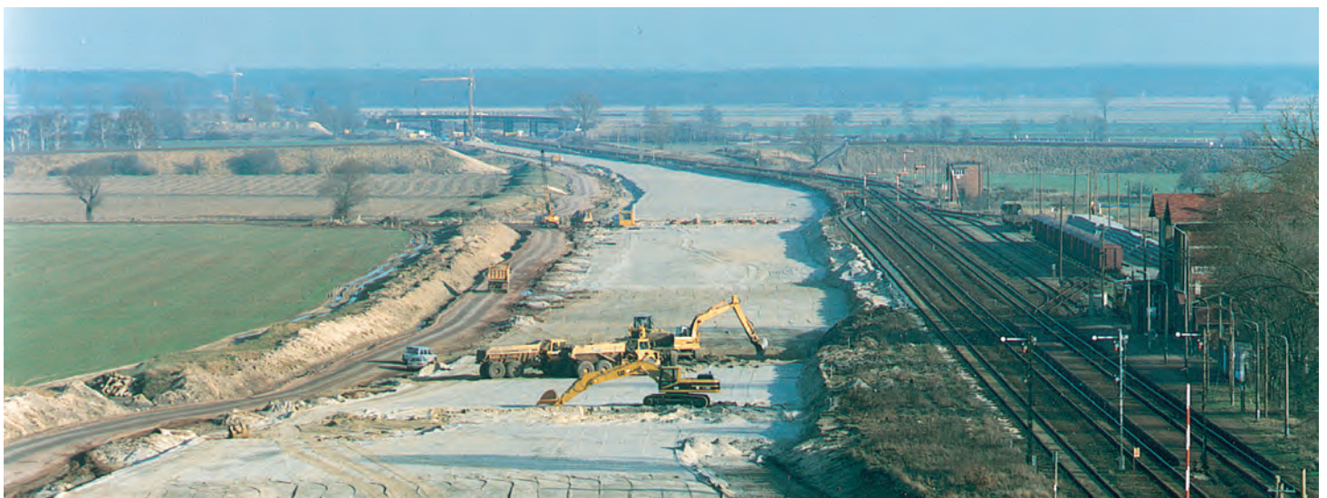
Erbauarbeiten für die Trasse bei Schönhausen.
