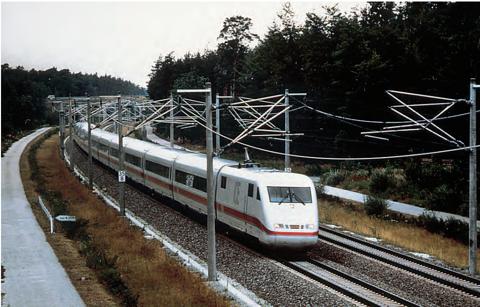
linkes Foto: Die neue Oberleitung Re 330 gewährleistet eine sichere Energieabnahme auch bei hohen Geschwindigkeiten
